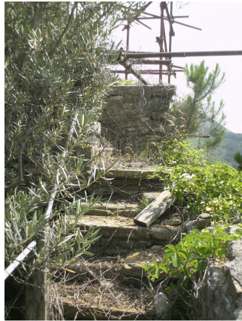
Le scale di accesso alla Torre/3
