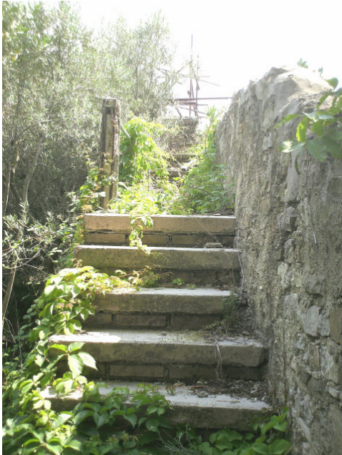
Le scale di accesso alla Torre/1
