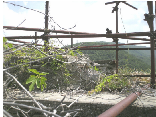
La Torre di guardia transennata: sullo sfondo il Busseto
