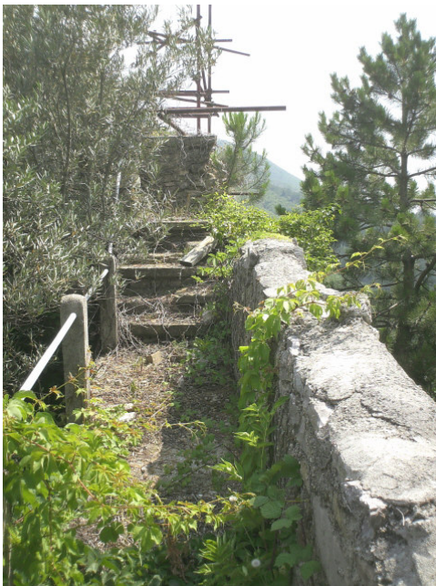
Le scale di accesso alla Torre/2
