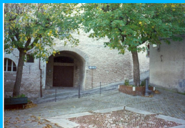
qui era eretta in epoca bizantina una torre, intorno alla quale si riuniva il popolo in adunanza: col tempo la costruzione fu abbandonata e ridotta a cisterna tonda, che dà il nome all'omonima via (foto Centini)
