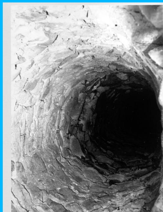
Foto n.4: INTERNO DEL POZZO
